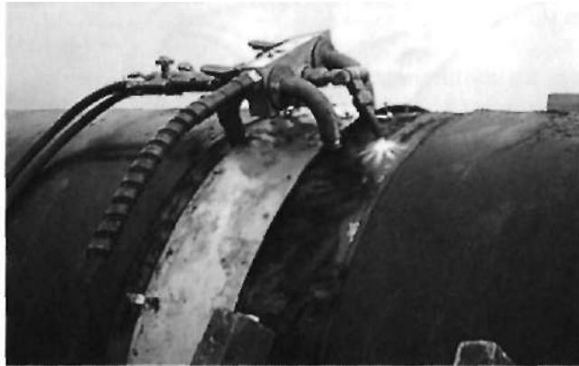
Рис. 2.11. Аппарат машинной резки фирмы CRC Evans
