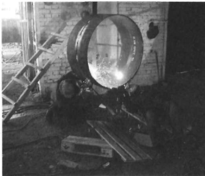
Рис. 5.3. Аттестация сварщиков — сварка кольцевого стыкового соединения
