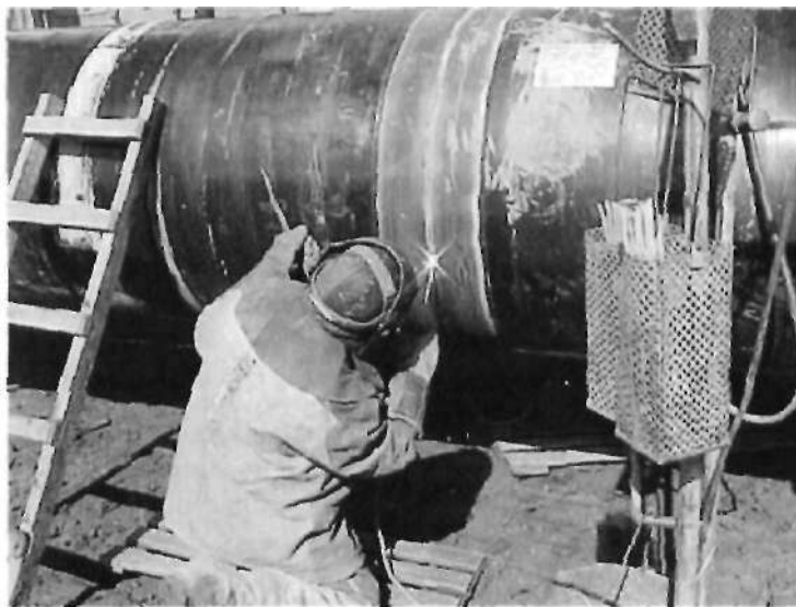
Рис. 3.5. Ручная электродуговая сварка в направлении сверху вниз
