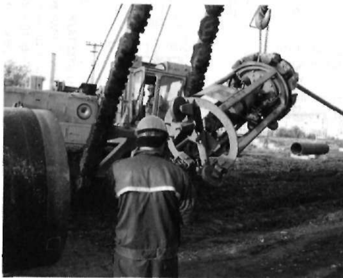
Рис. 3.29. Установка внутреннего центратора
