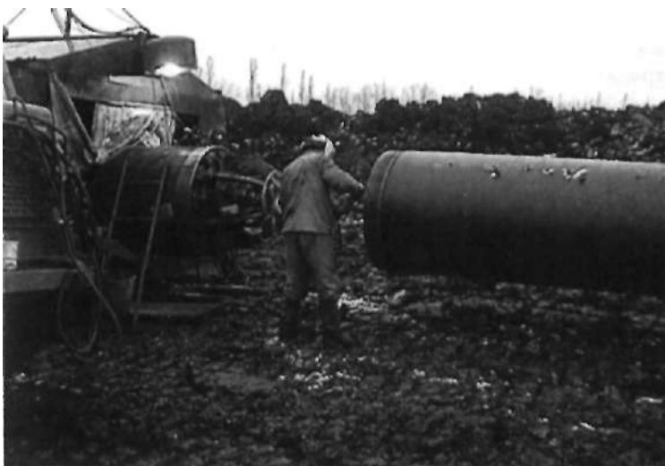
Рис. 2.3. Подготовка торцов труб и монтаж трубной секции
