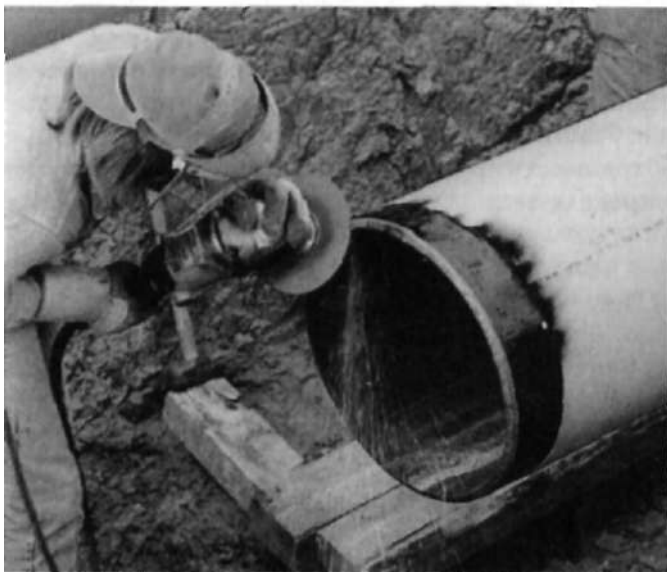
Рис. 2.1. Подготовка торцов труб к сварке
