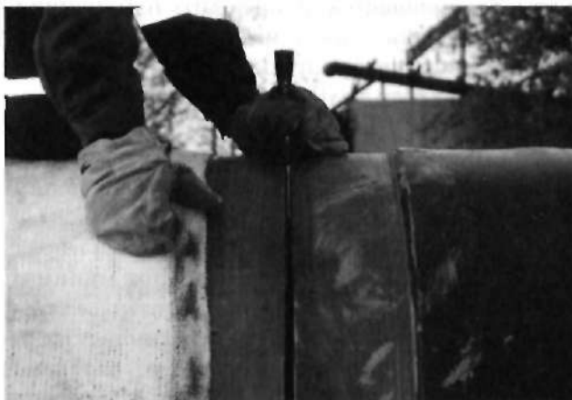
Рис. 3.69. Установка зазора
