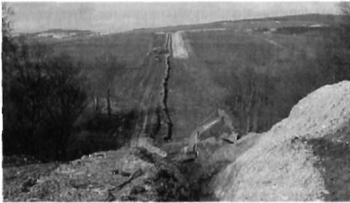
Рис. 3.34. Раскладка труб вдоль трассы
