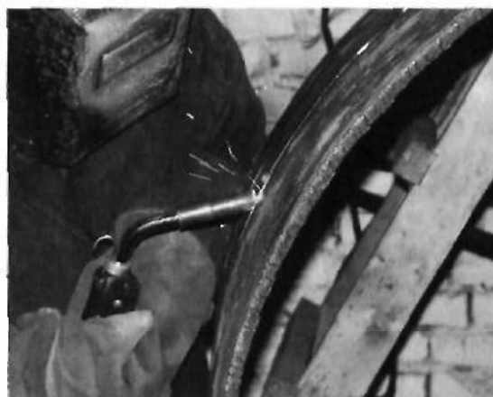
Рис. 3.48. Сварка процессом STT
