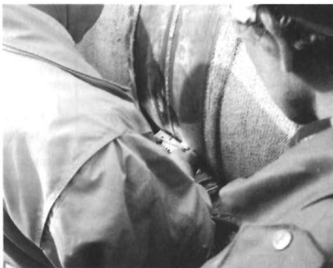
Рис. 5.5. Контроль сварного соединения шаблоном сварщика
