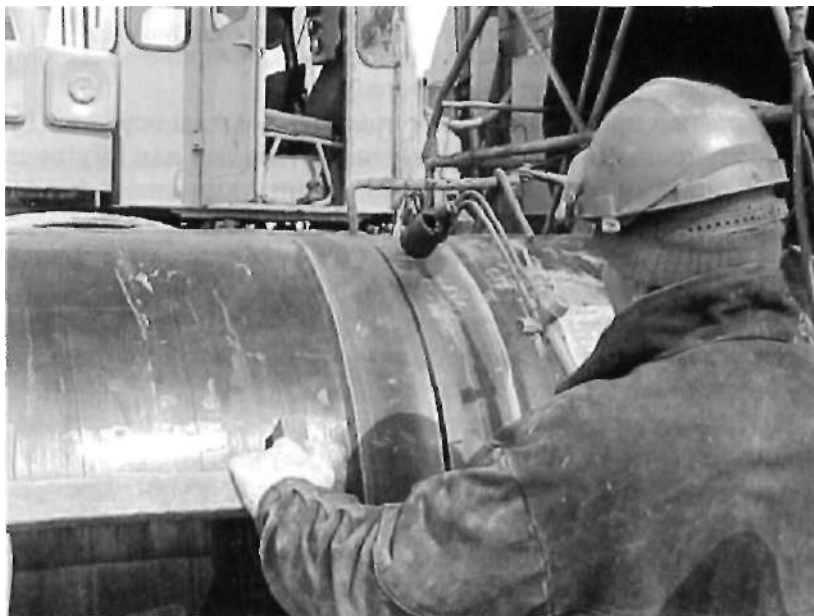
Рис. 2.4. Сушка кромок пропановой горелкой
