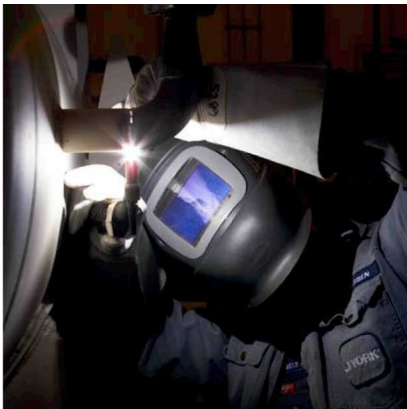
MMA сварка V-образной разделки
